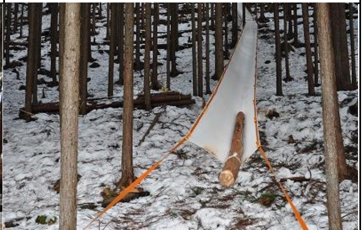
2段連結で約60mの搬送に大成功です 連結部のカーブの部分もスムーズに搬送できました。
