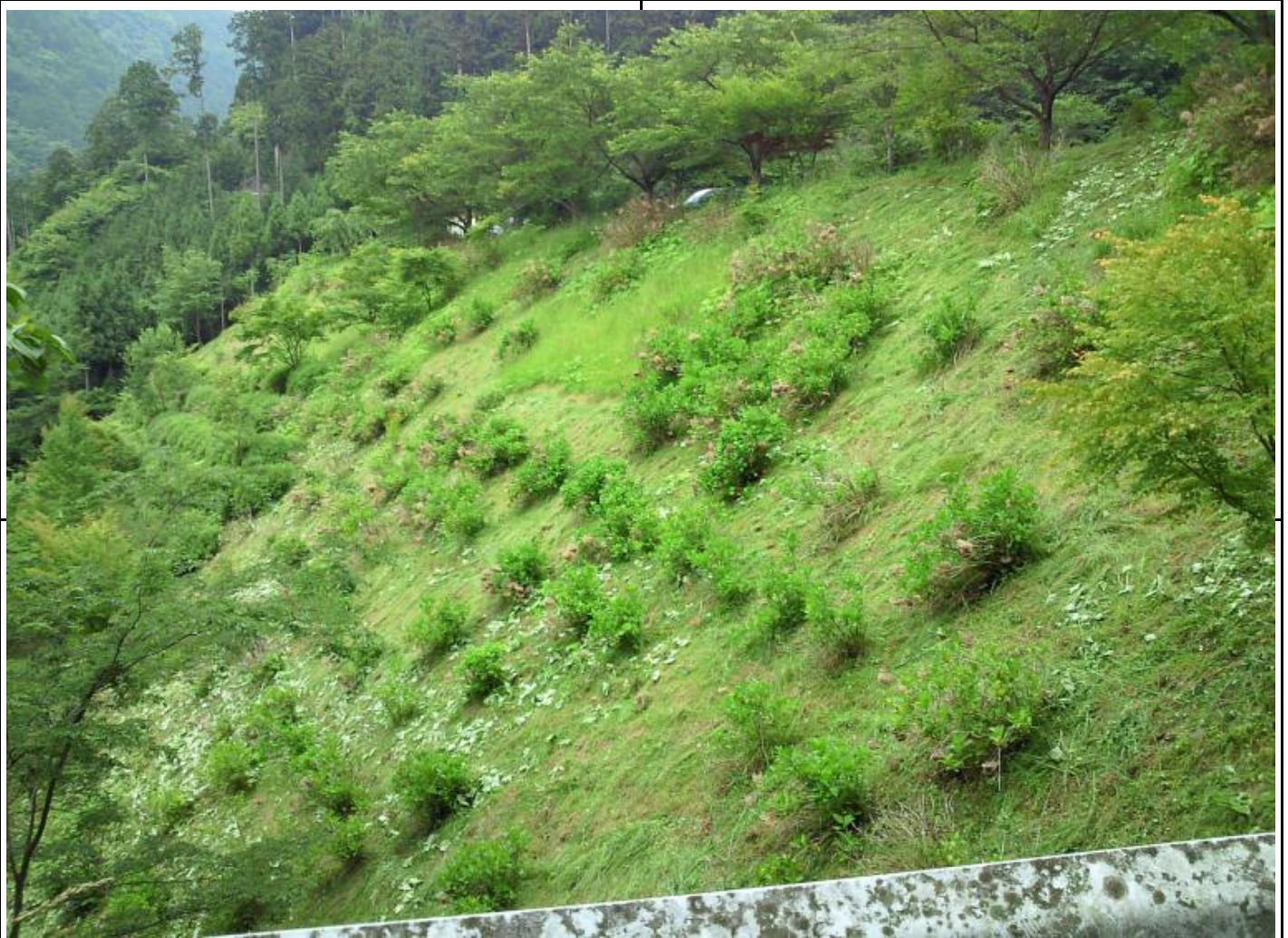
作業終了時、上部全体
